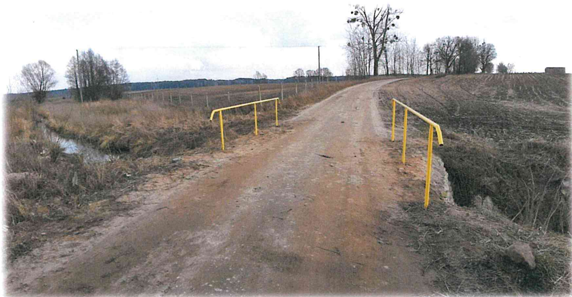
Rys. Montaż barier ochronnych na przepuście w ciągu drogi
