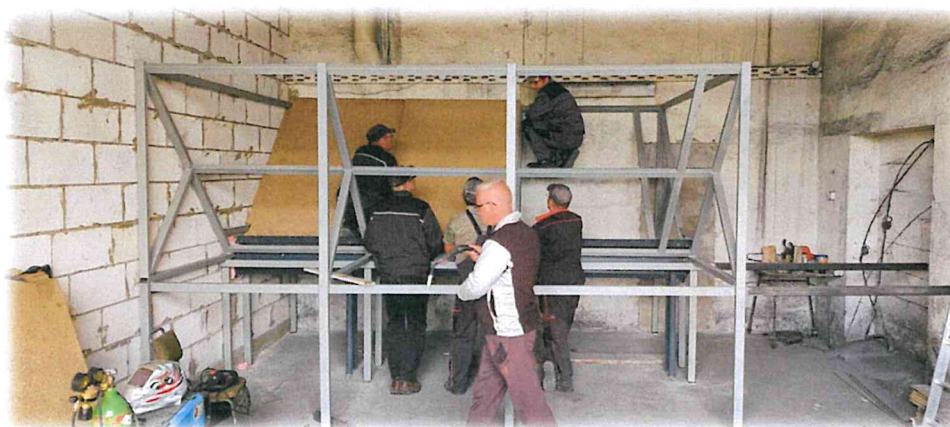
Rys. Kotłownia K-3 – Prace montażowe przy zasobniku paliwa
